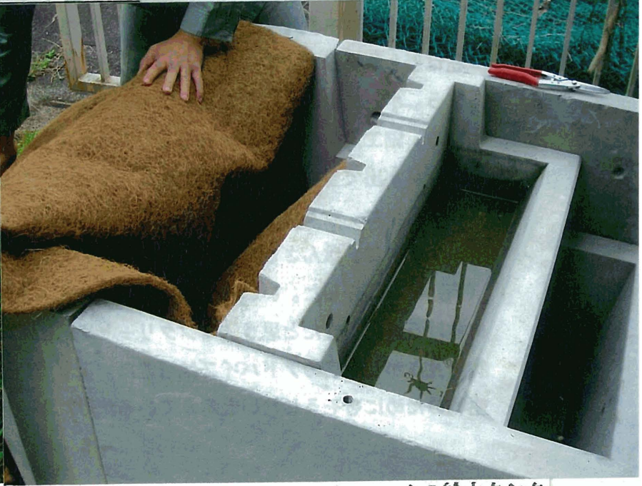
写真6 マザーズ・ロックの給水タンク
