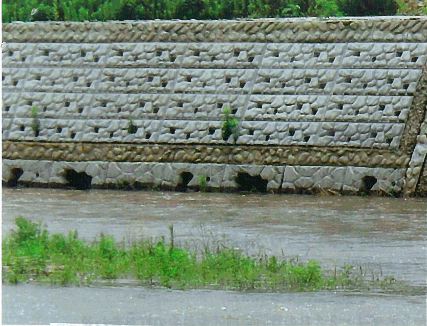
写真1 出石川の工事 (穴開きブロックと植物)
