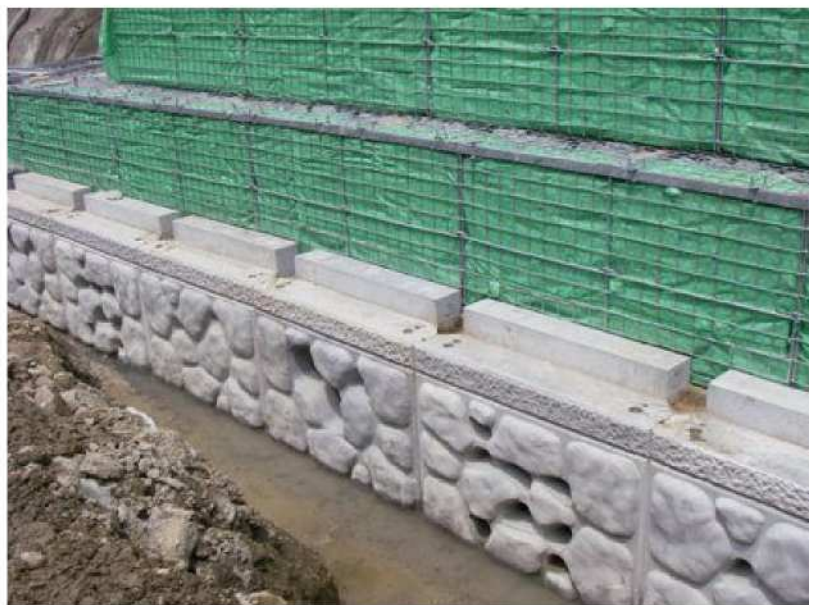
写真4 大はんざきブロック 75基が並ぶ工事区域
