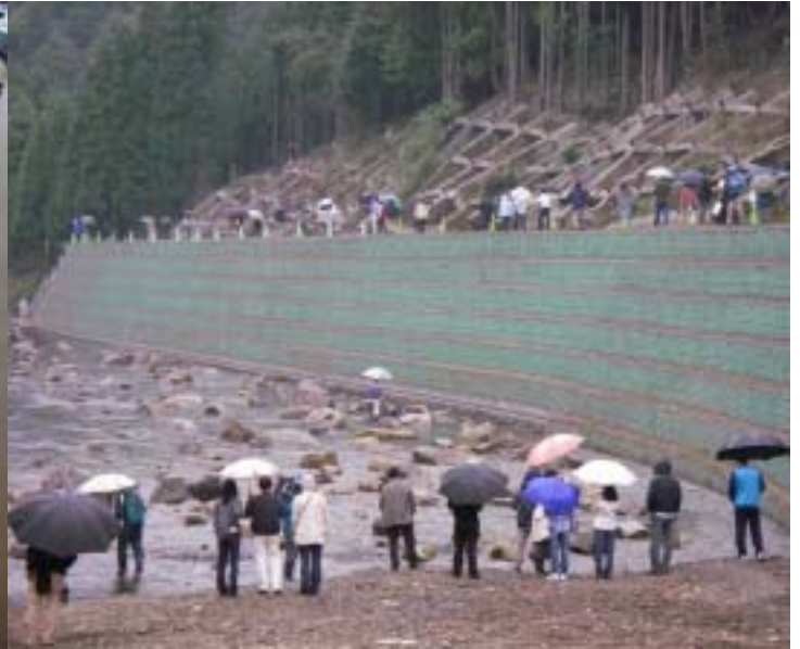
写真2 生野ダム下の工事現場視察
