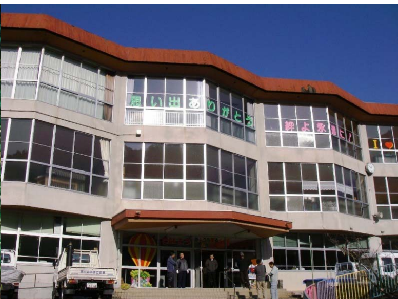
写真2 旧・生野町立奥銀谷小学校 (2009年3月閉校)
