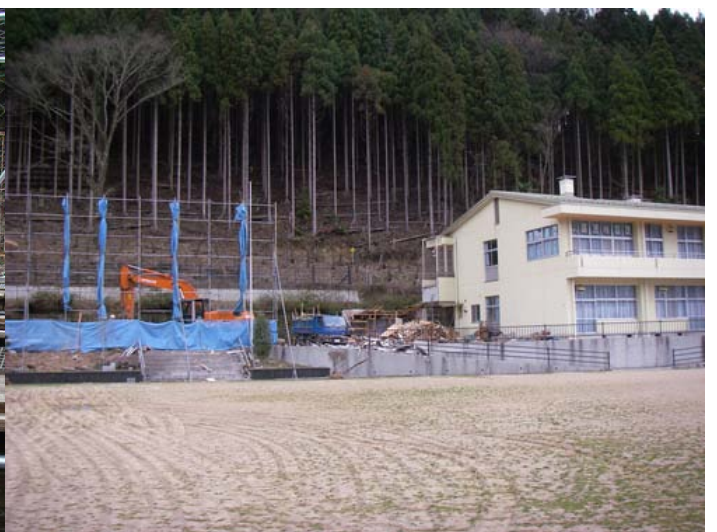
写真6 平成17年閉校の栃原小学校の解体
