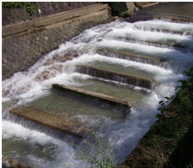
写真10 多段式全面魚道の倒れた隔壁(建屋川)
