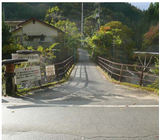
写真8 ボランティアの手で綺麗に塗装されたハンザキ橋
