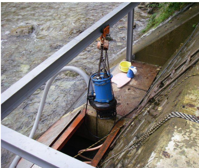
写真11 ポンプピットの排砂作業
